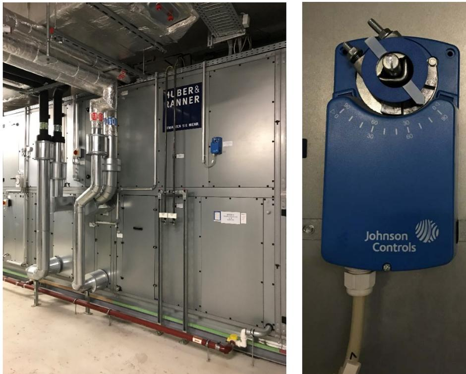
Abbildung 28: Untersuchte RLT-Anlage und defekte Bypassklappen-Steuerung
